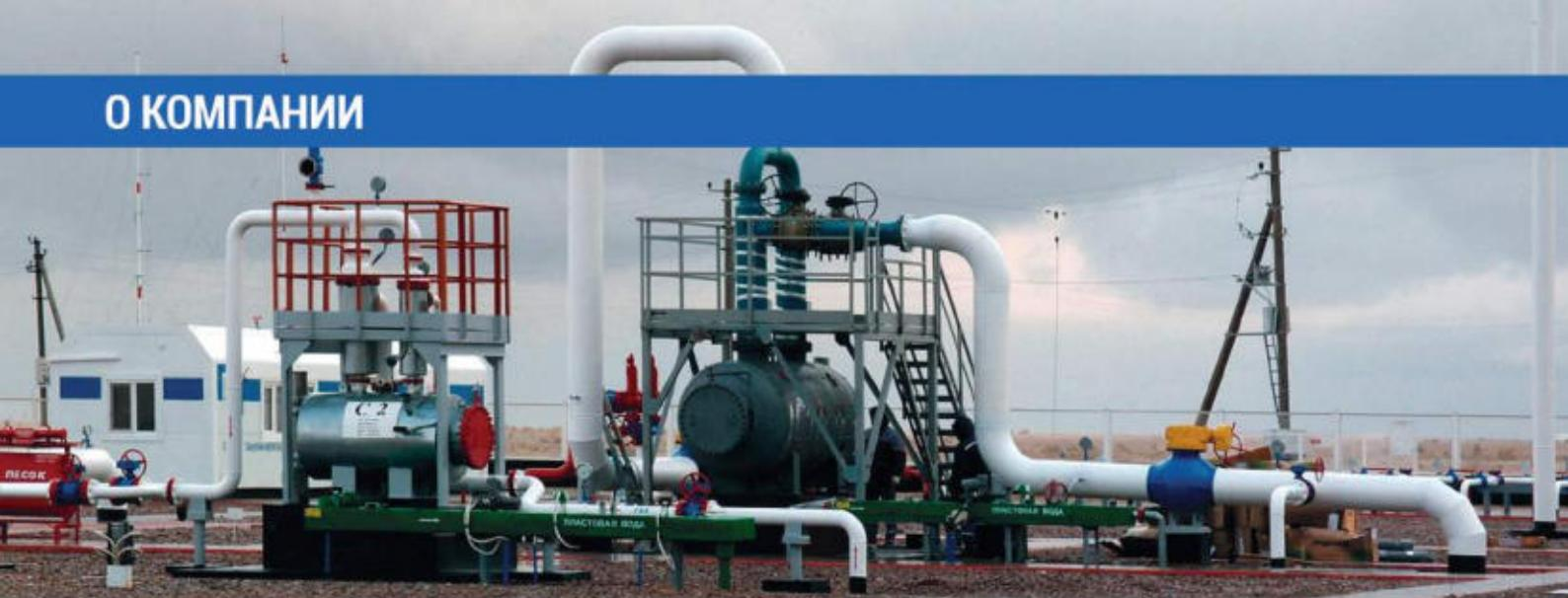
Сепарационный блок установки очистки природного газа от капельной жидкости (газовый конденсат, водометанольная смесь) и механических примесей. Проектное решение ЗАО «Газпром зарубежнефтегаз».
